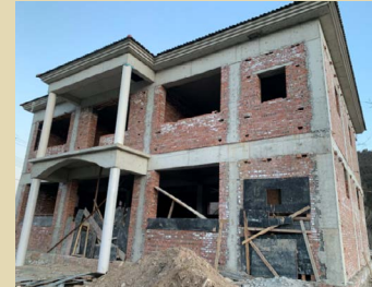
圈梁实际建造
