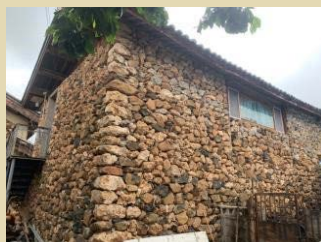
毛石墙体房屋
