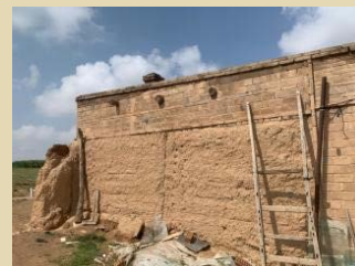
混杂结构房屋
