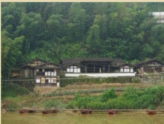
切坡建房，且边坡未进行处理
