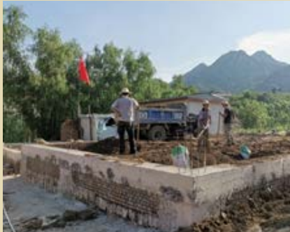
设置钢筋混凝土圈梁
