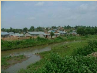
建于河滩、沟溪两岸且无堤防等防护设施
