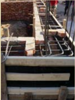
设置钢筋混凝土圈梁
