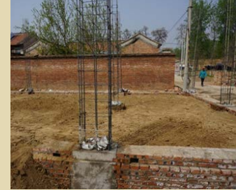
构造柱实际建造
