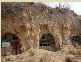
黄土窑洞出现竖向节理剥蚀
